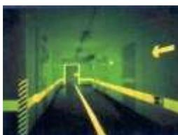
Флуоресцентная краска применяется для окраски отдельных деталей, нанесения сигнальных линий и знаков на автомобильном, железнодорожном транспорте, на самолетах и вертолетах, а также для окраски навигационного оборудования, маяков, бueв, дорожных знаков, радиобueв, для маркировки опасных участков технологических линий, противопожарного инвентаря.
